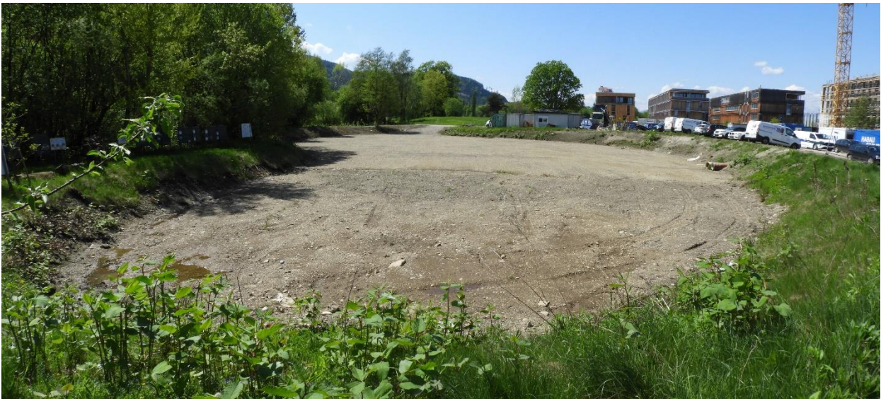
Abb. 8: älteres im Umbau befindliches Retentionsbecken B im Südosten der Gebäude (28.04.2025)
